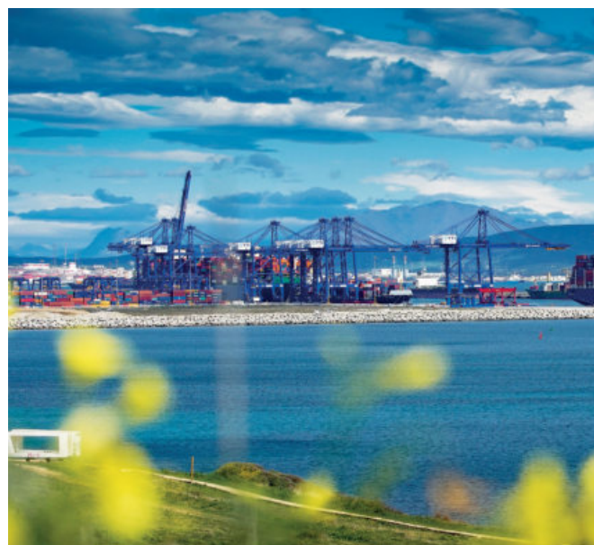
Vista de las instalaciones del puerto de Algeciras.
