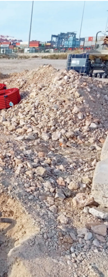
El Puerto de Barcelona inicia las obras para instalar el primer OPS en la terminal de BEST.
