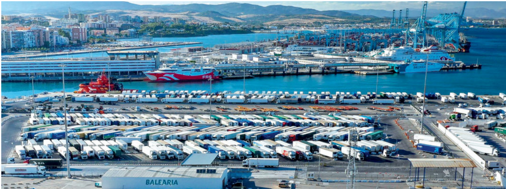
Vista de la terminal de transporte pesado en el puerto de Algeciras.
